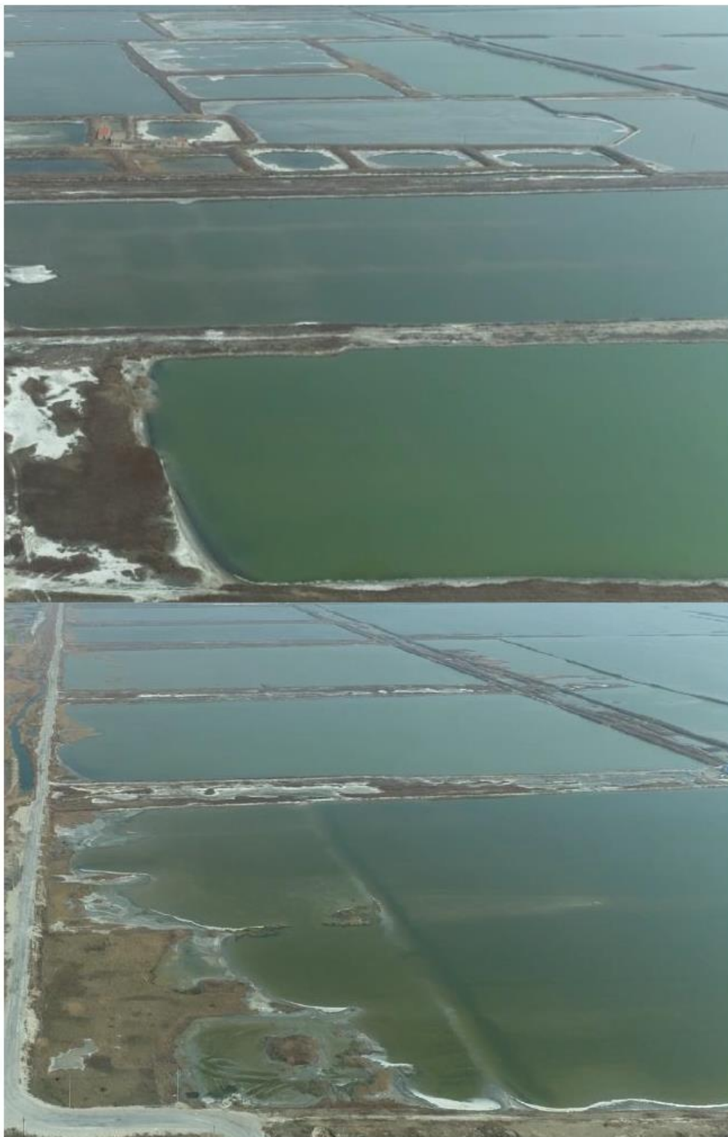
湖内堤埝现状
