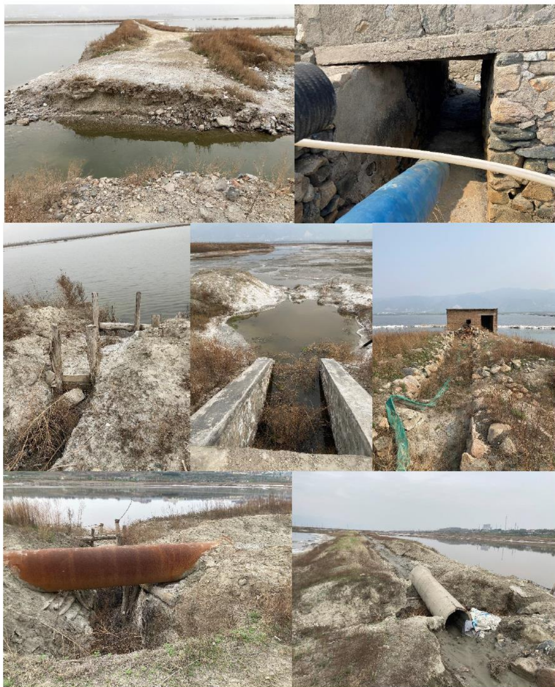
湖内畦田间连通建筑现状
